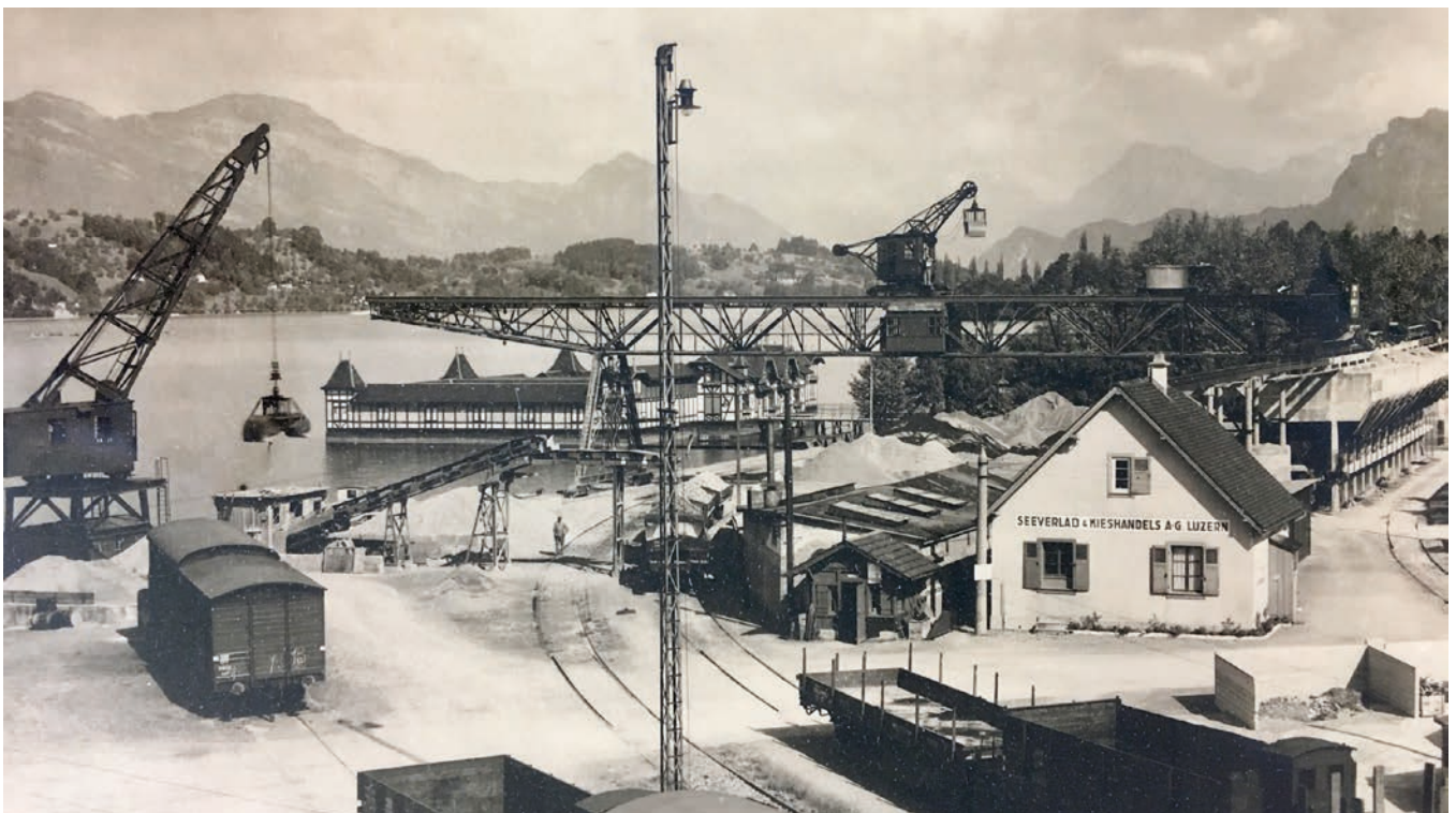
Vor 100 Jahren startete Alfred Schätzle hier am Alpenquai, nur unweit des heutigen Betonwerks, seine Umschlagsanlage für Kies, Schotter und andere Güter
